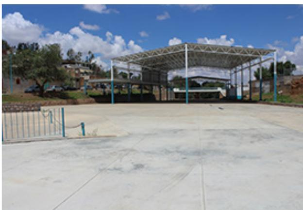
**Construcción de 2,000 m<sup>2</sup> de Domo a base de estructura metálica y 2 juegos de sanitarios con una superficie de 40 m<sup>2</sup> a base de block pesado en la Explanada del Embovedado Municipal.**
