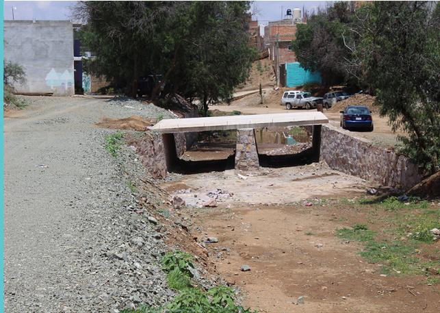
**Construcción de Puente Vehicular de 20 M. por 10 M. de largo, mediante concreto premezclado, incluye Red de Alcantarillado y Colector Pluvial en Calle Nueva, en Cabecera Municipal. (1)**
