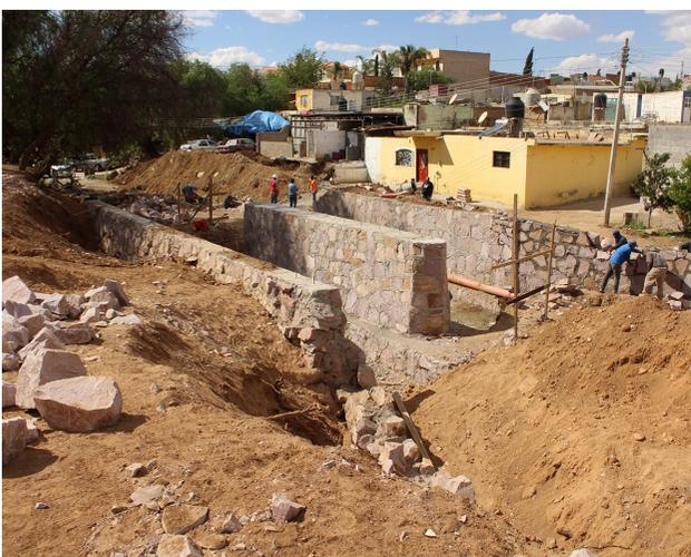
**Construcción Puente vehicular de 20 mts. por 10 M. de largo, mediante concreto premezclado, incluye Red de Alcantarillado y Colector Pluvial en Calle Nueva, en Cabecera.**
